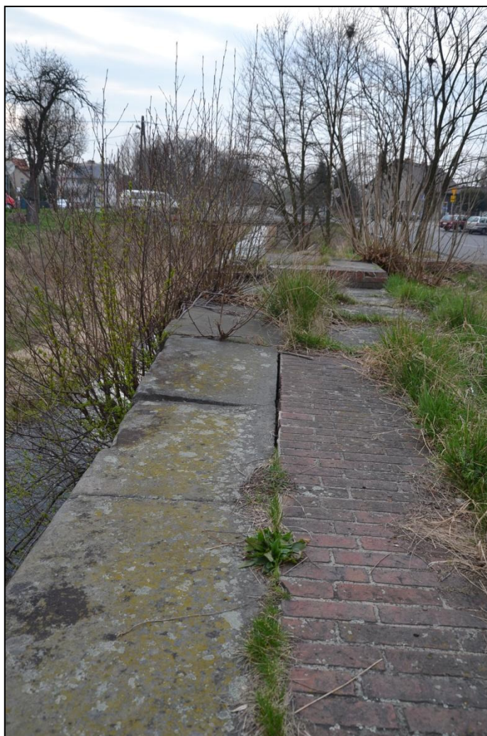
Rys.58. Klawiszowanie bloków kamiennych korony – spowodowane przez wrastające się w ścianę drzewa. Zdjęcie z dnia 01.04.2014
