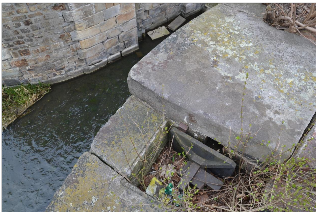
Rys.57. Brak klapy w jednej z wnęk w której mocowane są zawiasy i młode drzewa wyrastające z zagłębienia. Zdjęcie z dnia 01.04.2014
