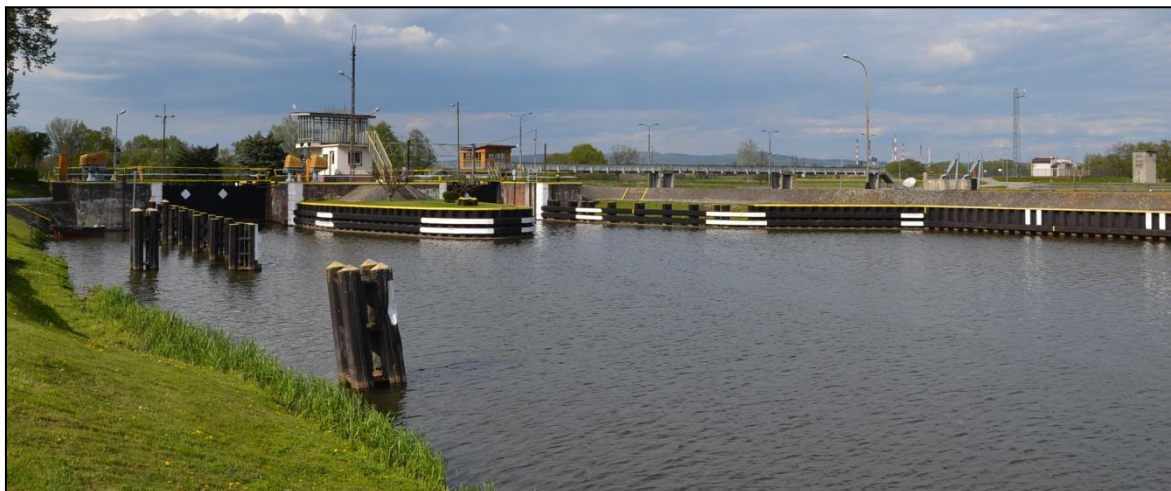
Rys.37. Prowadnice i kierownice w górnym awanporcie śluzy bliźniaczej zlokalizowanej na rzece Odrze w miejscowości Januszkowice. Kwiecień 2014
