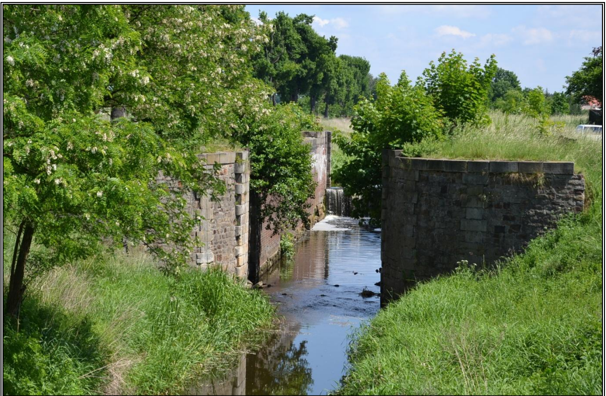
Rys.63. Widok na śluzę od strony wody dolnej. Zdjęcie z dnia 15.05.2014
