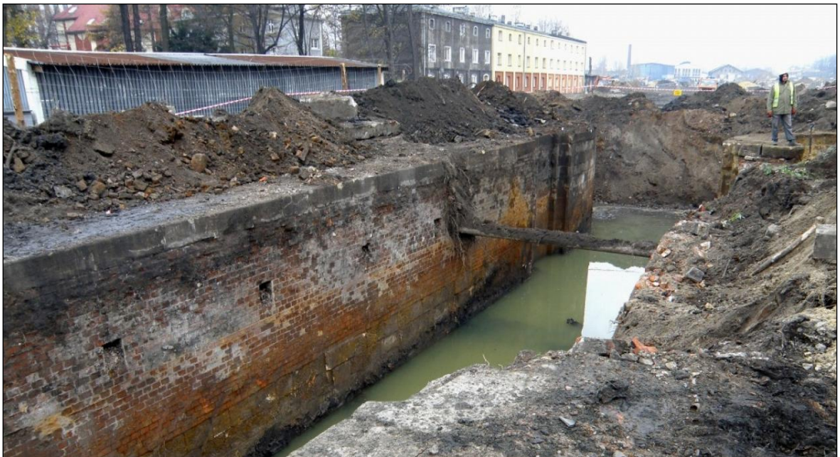
Rys.47. Widok na śluzę komorową numer 18, odkrytą podczas robót budowlanych. Gliwice, 18.11.2013 [28]
