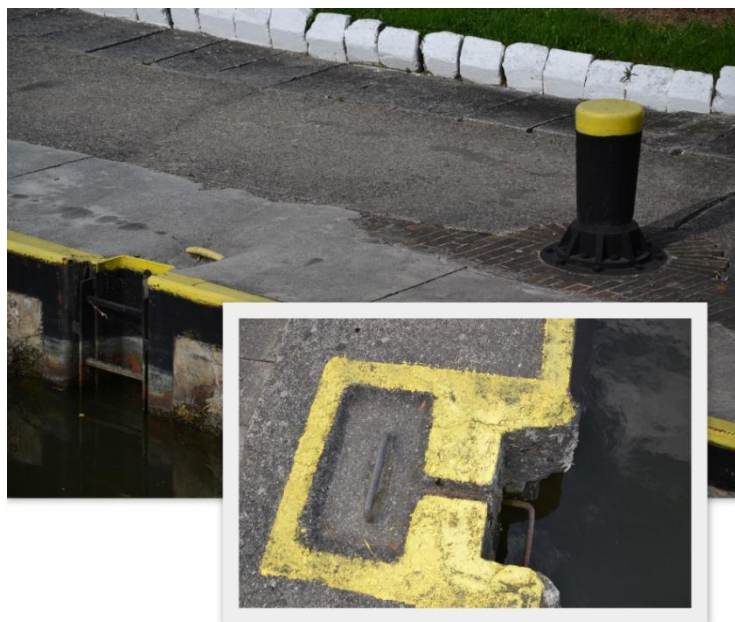
Rys.30. Widok na drabiny ścienne w śluzy Januszkowice. Zdjęcia z dnia 20.04.2014. Na drugim planie widoczny polder nabrzeżny
