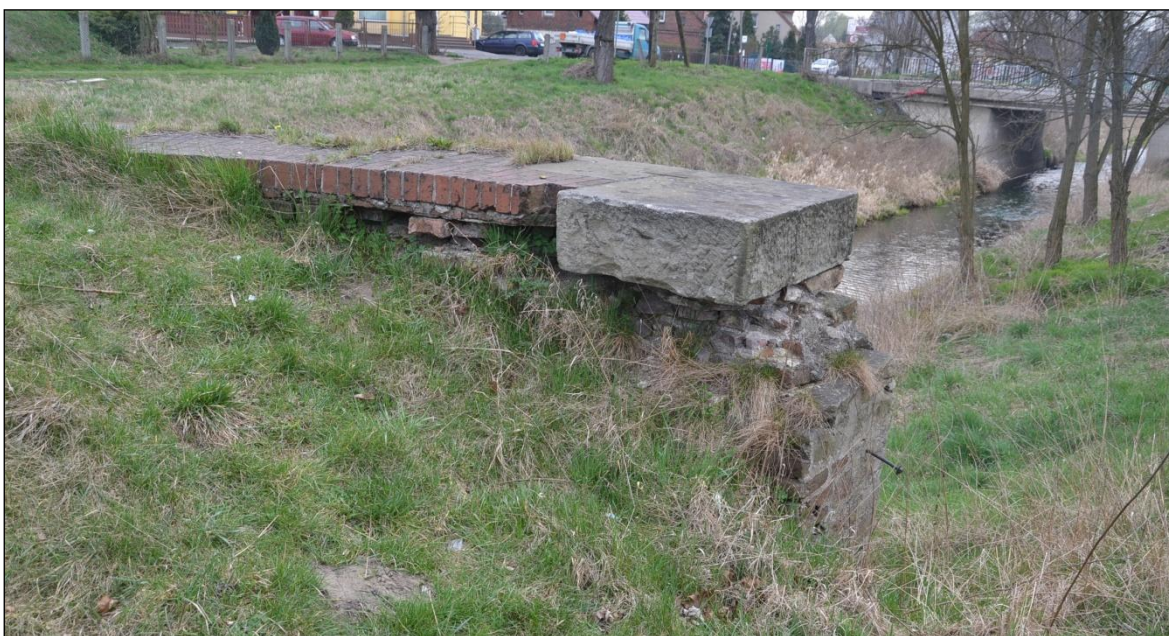
Rys.60. Braki w materiale i częściowo odsłonięty przez osiadającą ziemię mur oporowy łączący głowę dolną ze prawym brzegiem. Zdjęcie z dnia 01.04.2014
