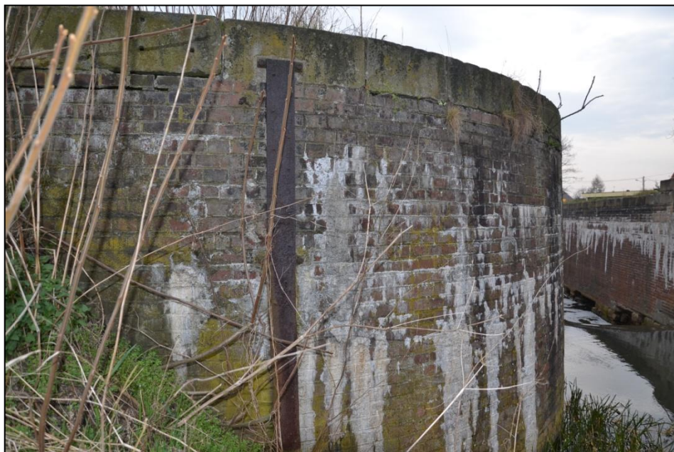
Rys.55. Zachowana łąta wodowskazowa oraz liczne wykwity solne na powierzchni muru oporowego łączącego głowę górną ze skarpą nasypu. Lewy brzeg, zdjęcie z dnia 01.04.2014
