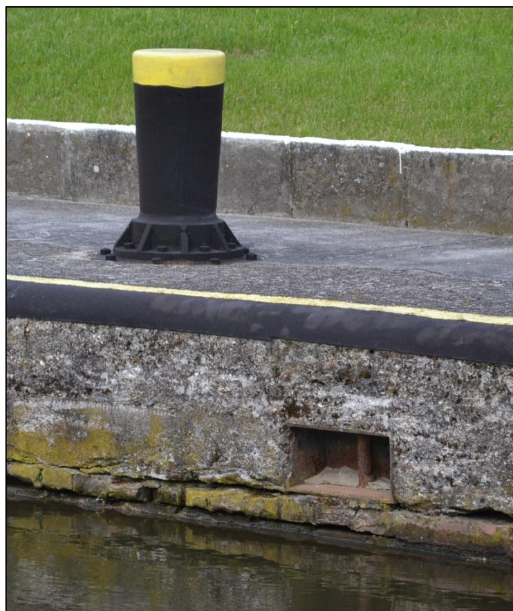
Rys.26. Pachoły cumowniczy nabrzeżny i ścienny zlokalizowane w pobliżu śluzy Januszkowice. Zdjęcie z dnia 21.04.2014
