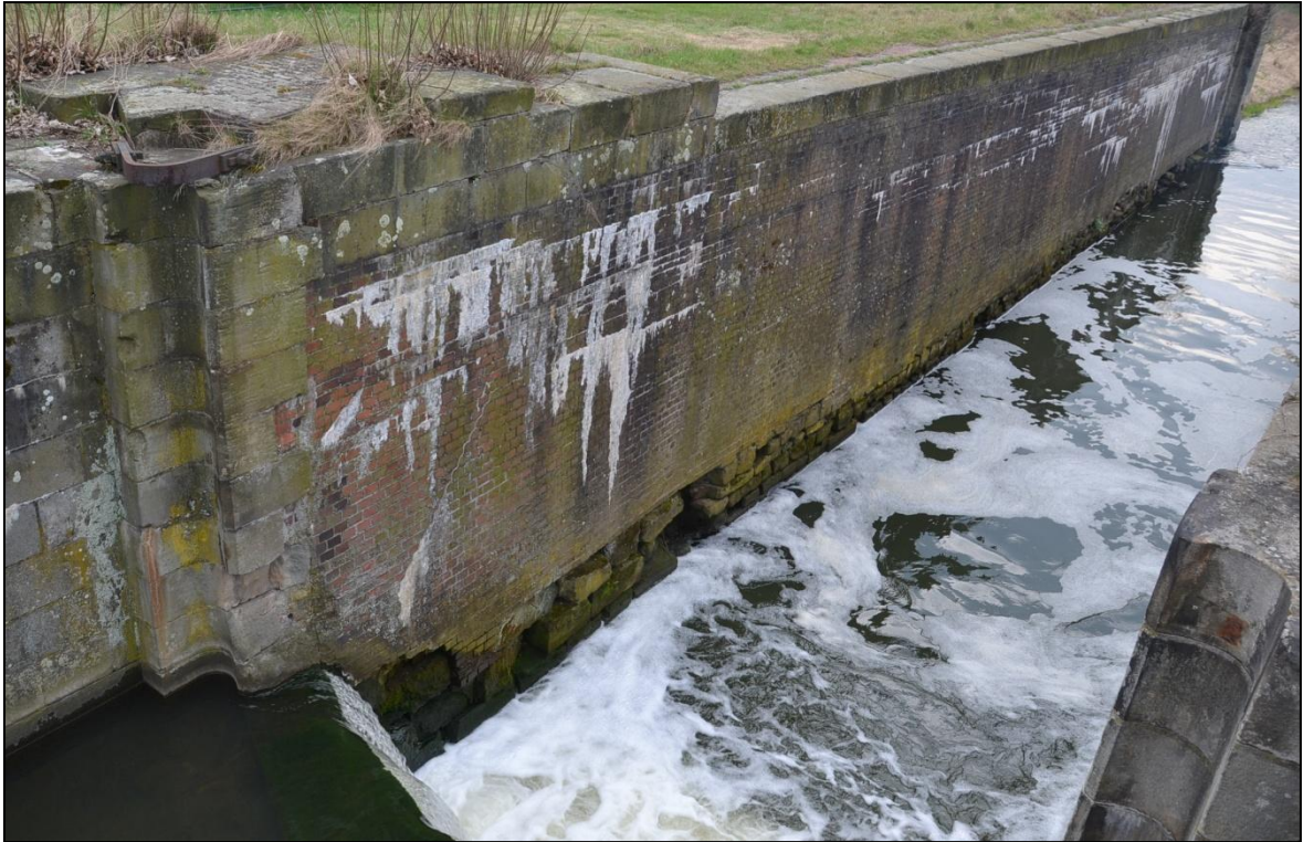
Rys.62. Widoczne liczne wykwyty solne na powierzchni ścian, i ubytki materiałowe w dolnej części lewej ściany komory. Zdjęcie z dnia 01.04.2014
