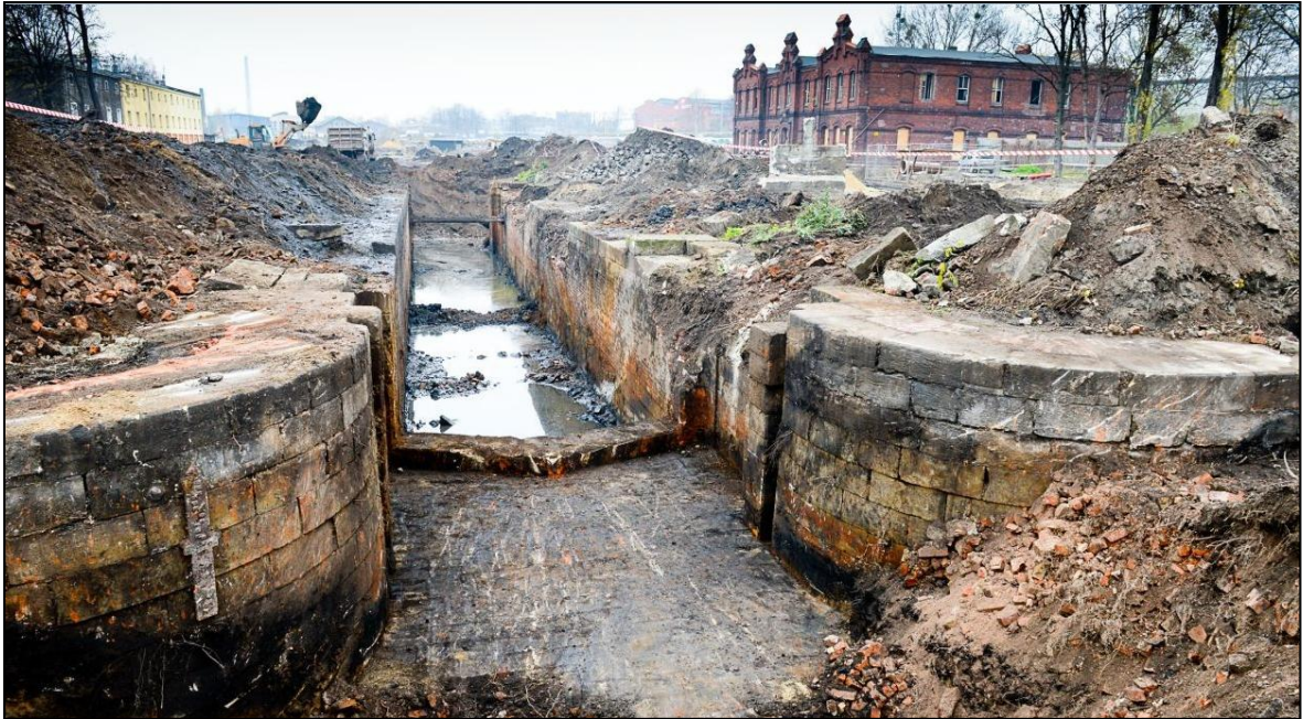
Rys.46. Widok na śluzę komorową numer 18, odkrytą podczas robót budowlanych. Gliwice, 18.11.2013 [28]
