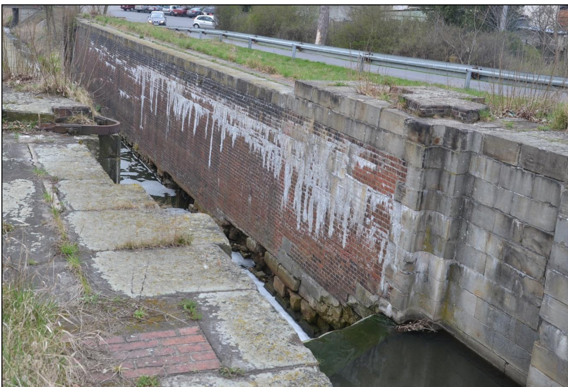
Rys.61. Widoczne liczne wykwyty solne na powierzchni ścian, i ubytki materiałowe w dolnej części prawej ściany komory. Zdjęcie z dnia 01.04.2014
