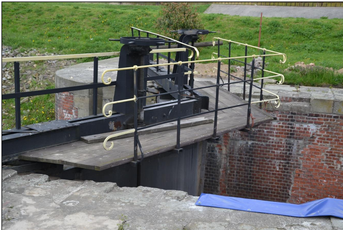
Rys.31. Fotografia pomostu komunikacyjnego na śluzie komorowej w Koźlu. Zdjęcie z dnia 20.04.2014
