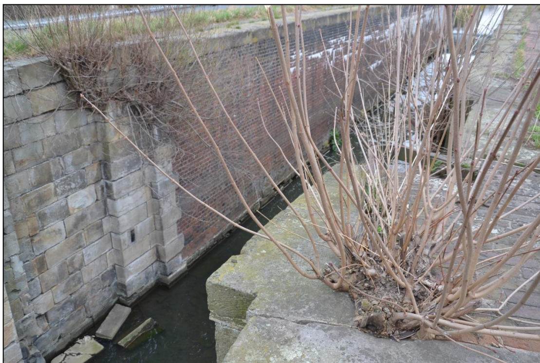
Rys.53. Młode drzewa wyrastające z korony i ściany głowy dolnej. Zdjęcie z dnia 01.04.2014
