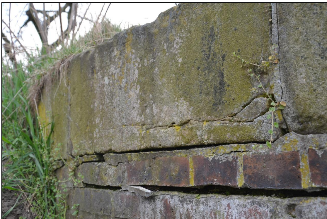
Rys.56. Ubytki w spoinowaniu, brak spójności między materiałami i zarysowania kamiennych ciosów korony. Mur oporowy łączący górną głowę z lewym brzegiem. Zdjęcie z dnia 01.04.2014
