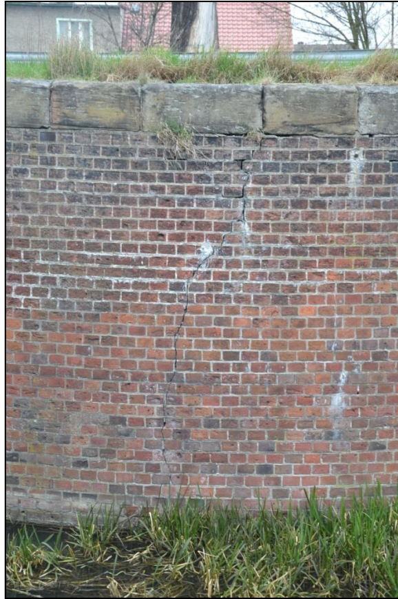
Rys.54. Pęknięcie ceglanego muru oporowego łączące głowę górną z prawą skarpą nasypu. Zdjęcie z dnia 01.04.2014
