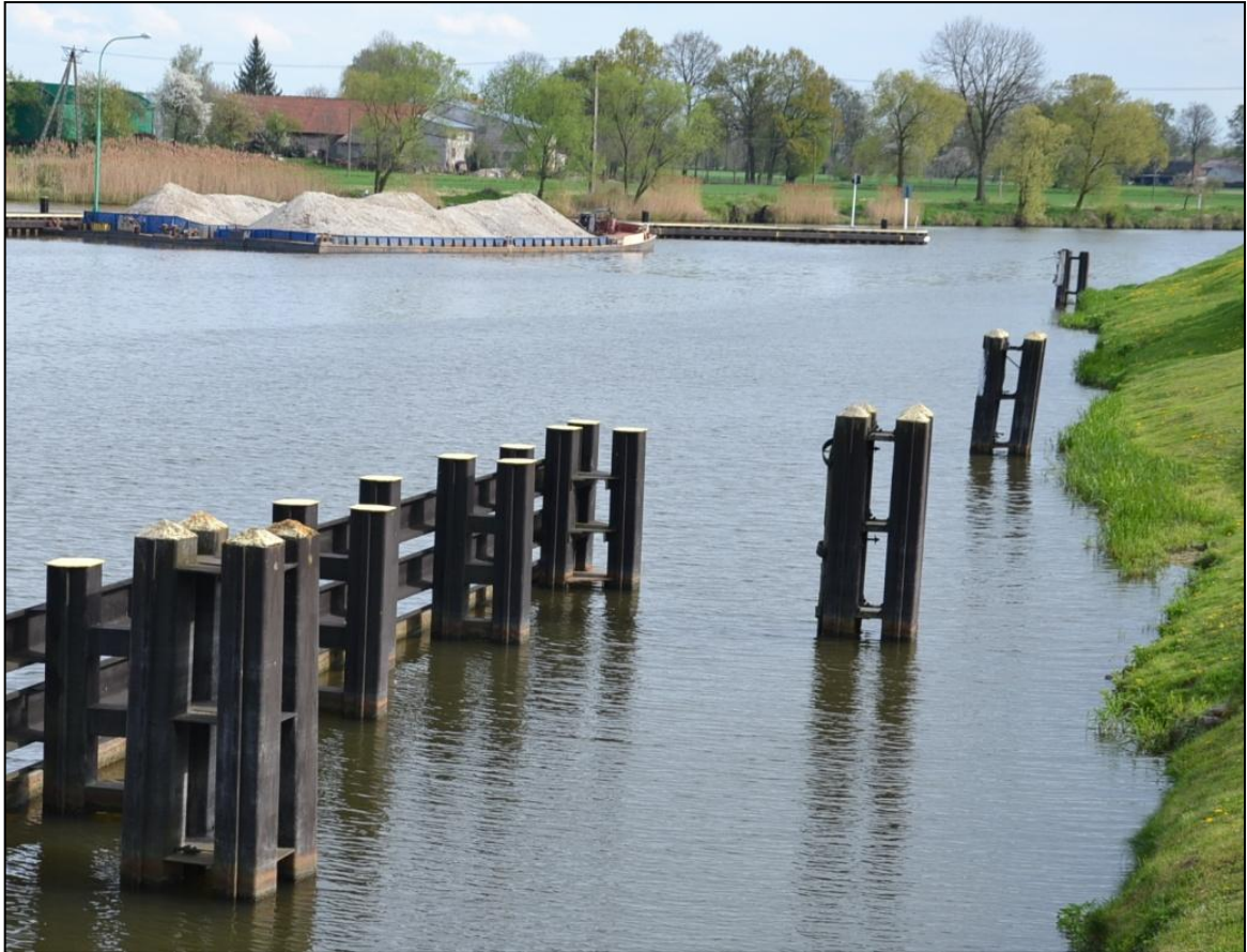
Rys.38. Linia cumownicza z dalb stalowych w górnym awanporcie w miejscowości Januszkowice. Kwiecień 2014
